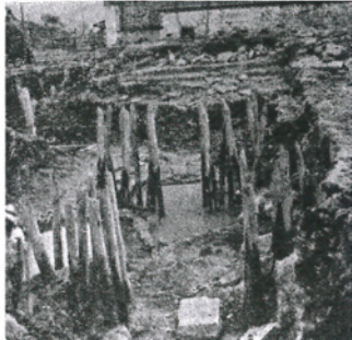
4. 码 III 临水面布桩情况
