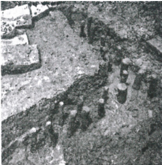
2. 码 I 北角布桩情况
